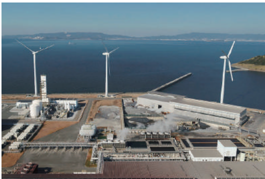
田原工場の圧延水処理設備
