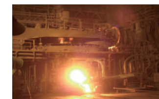
九州工場の電気炉
