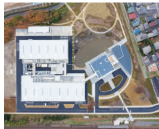
前田建設工業株式会社「ICI Lab」 ※前田建設工業 (株) HPより引用
