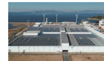
太陽光パネルを設置した田原工場製品倉庫屋根
