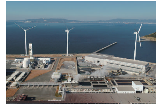
田原工場の庄延水処理設備
